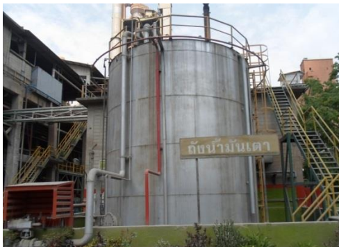
ภาพที่ 1.11 สภาพถังเก็บน้ำมันเตาและถังเก็บน้ำมัน Day Tank
